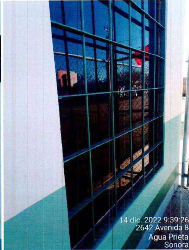
SE APRECIA PINTURA VINILICA EN MURO EXTERIOR Y PINTURA ESMALTE EN REJA DE VENTANA
