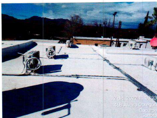
IMPERMEABILIZACION DE LOSA DE AZOTEA Y COLOCACION DE TINACO
