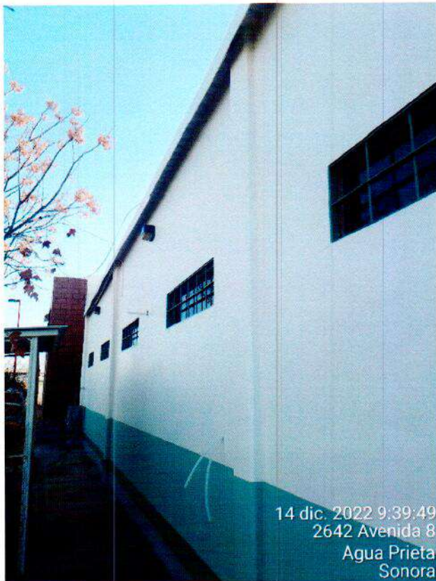
SE APRECIA PINTURA VINILICA EN MURO EXTERIOR Y PINTURA ESMALTE EN REJA DE VENTANA
