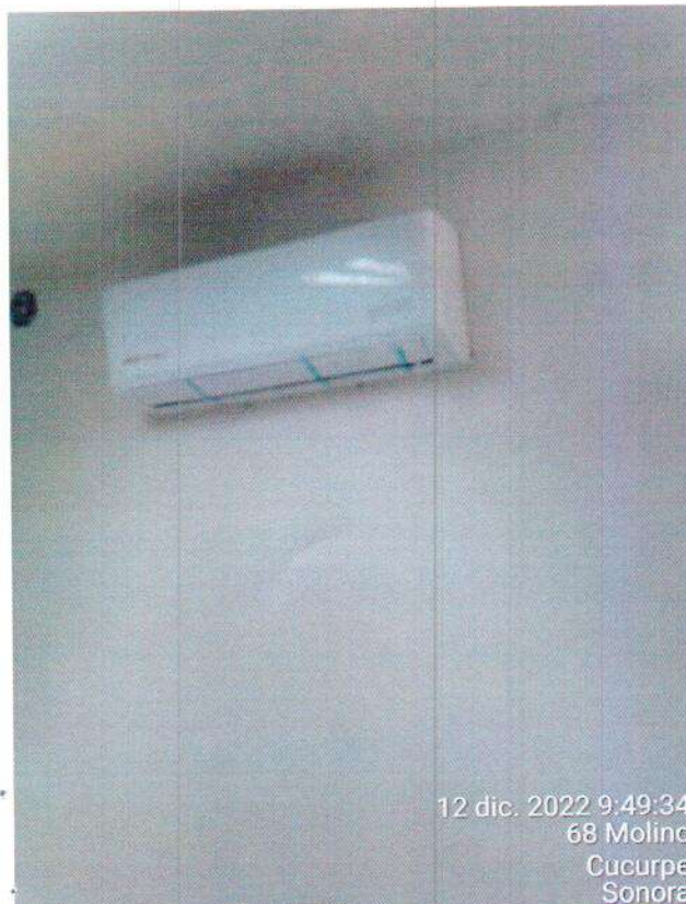
EN ESTAS IMÁGENES SE APRECIA, MINISPLIT DE UNA TON. Y VITROPISO
